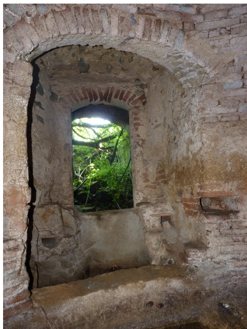
Accesso al sistema di captazione
