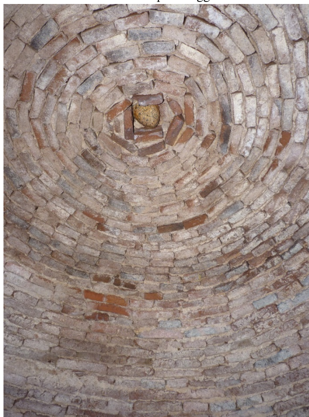
Volta della vasca di decantazione
