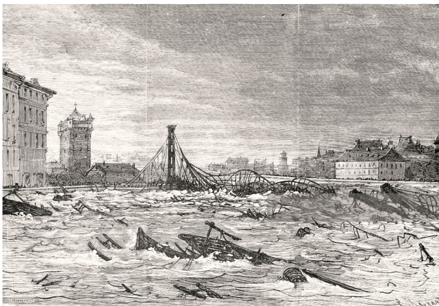
Il ponte Saint-Pierre a Tolosa dopo l'inondazione
