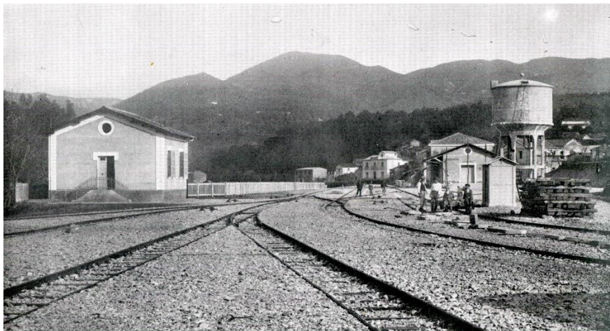
La stazione di Cinquefrondi in fase di completamento
