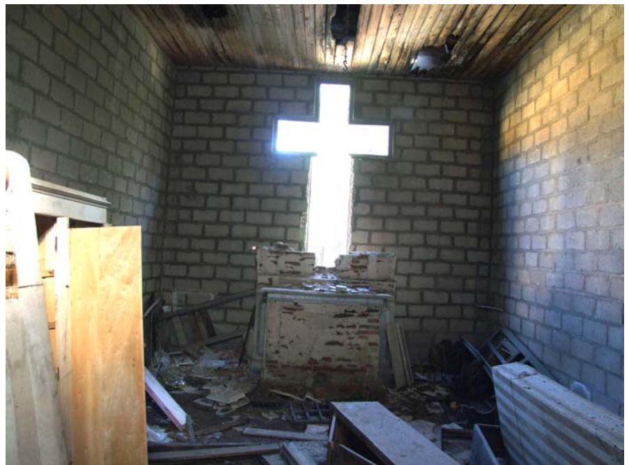
Stato attuale dell'interno della cappella fatta oggetto di vandalismi vari
