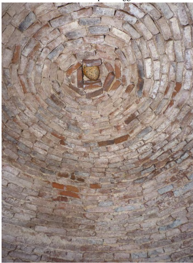
Volta della vasca di decantazione
