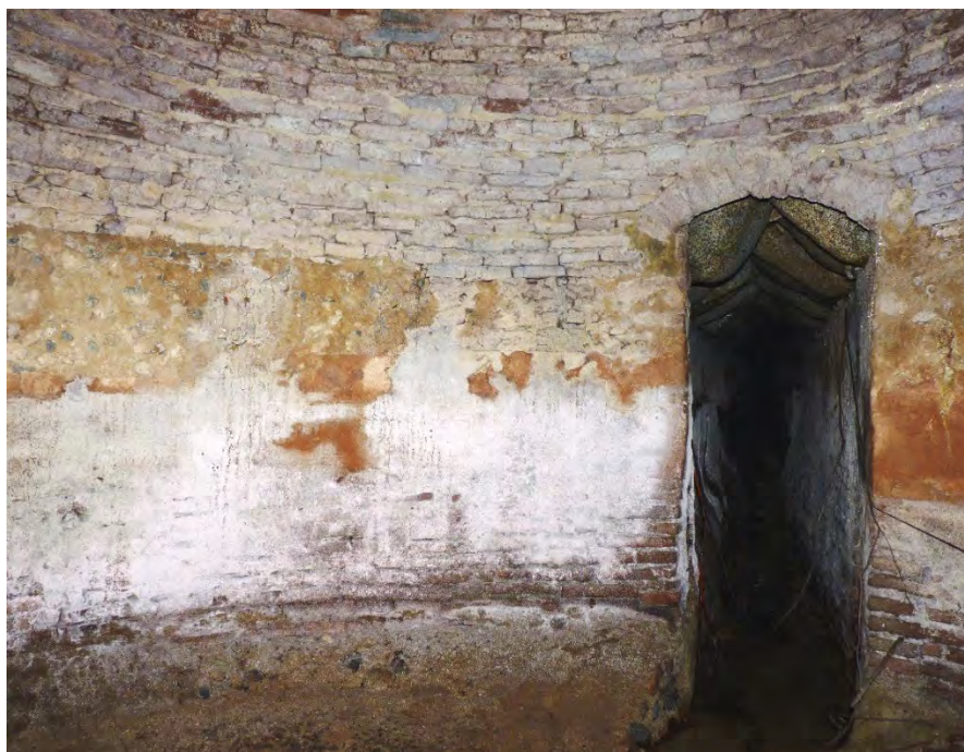
La vasca di decantazione
