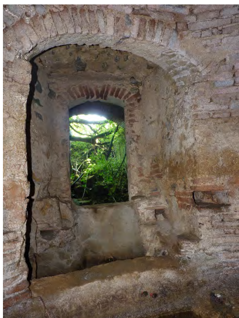
Accesso al sistema di captazione
