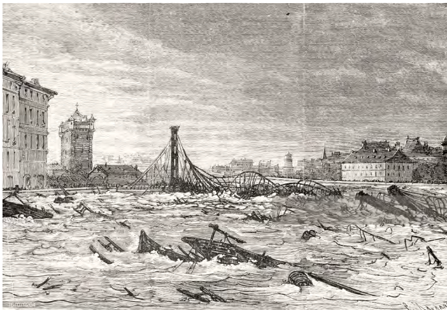
Il ponte Saint-Pierre a Tolosa dopo l'inondazione
